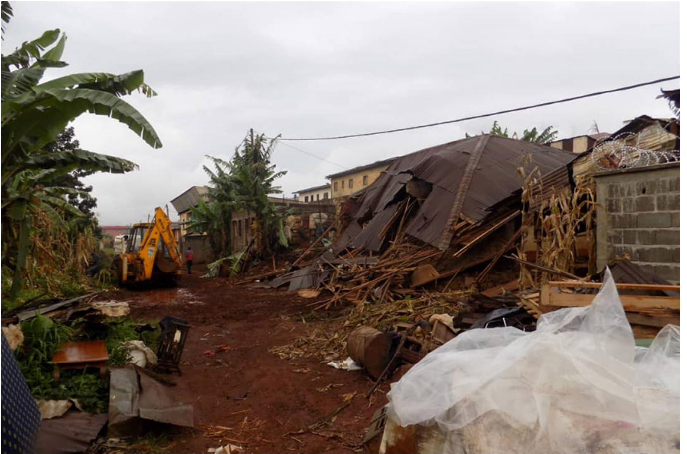
Maison en ddémolition après l'expulsion forcée de ses occupants.
